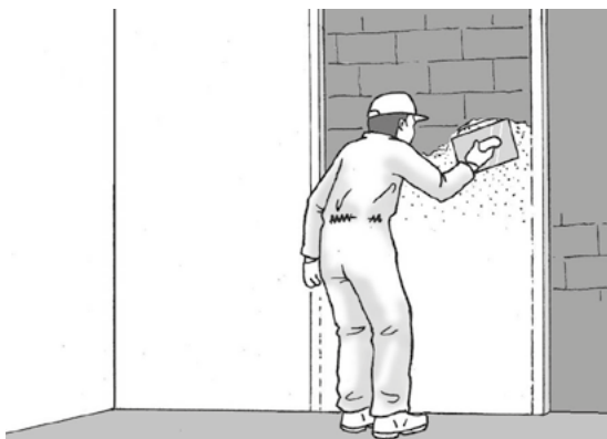
Figuras 30 y 31: Con una mira apretada contra otras dos se consiguen maestras del mismo espesor
