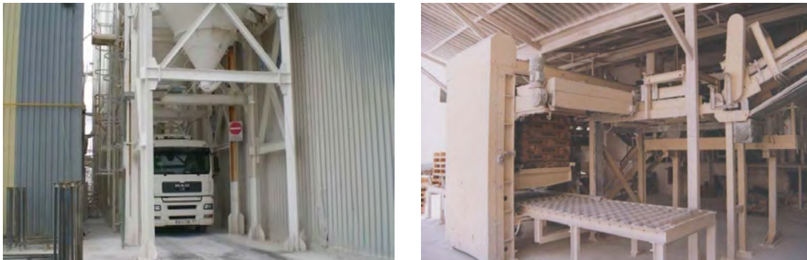
Figura 9: Silos en fábrica
