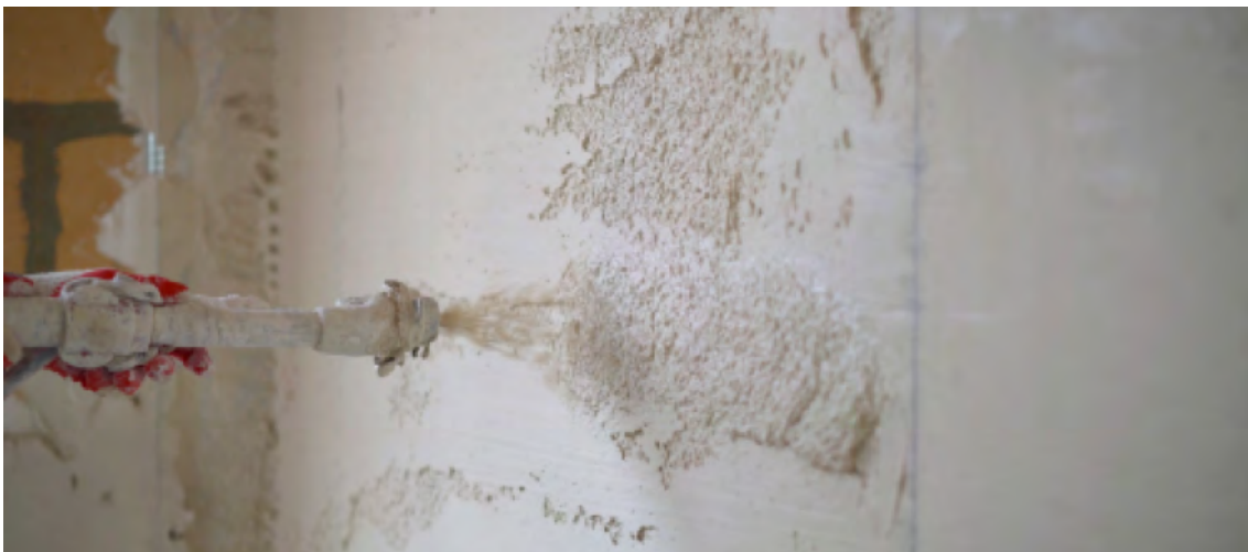
Figura 10. Aplicación de un producto de yeso aplicado con una máquina de proyección
