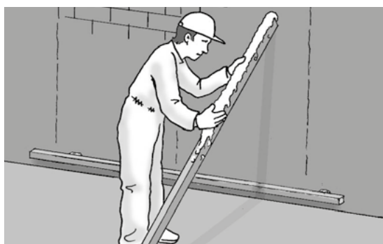
Figura 28. Aplicación de la pasta de yeso
