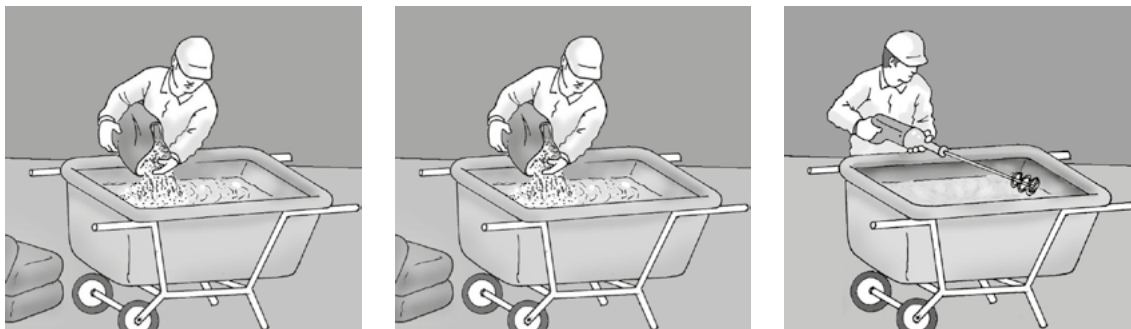
Figura 17. Vertido del yeso sobre el agua y amasado mecánico
