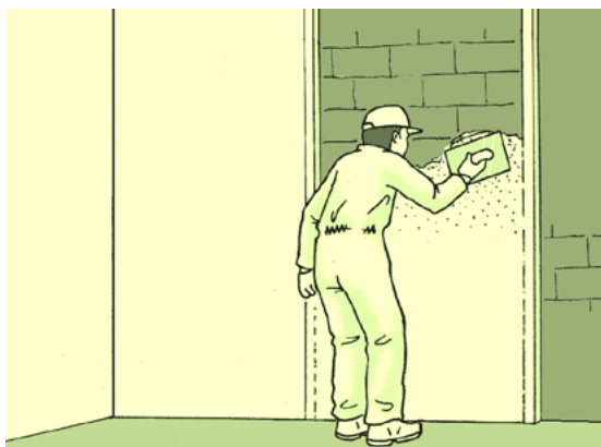
Figura 32. Tendido del yeso entre miras
