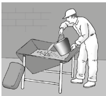
Figura 14. Vertido del agua
