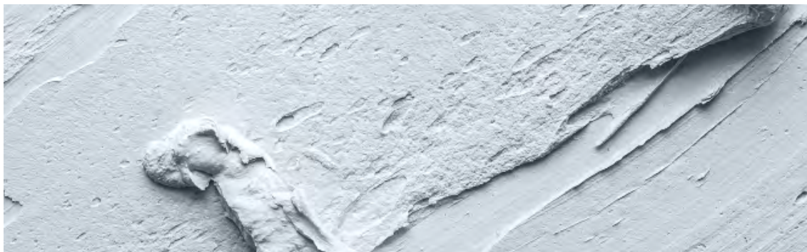
Figura13 . Apliación de la pasta de yeso en un paramento.
