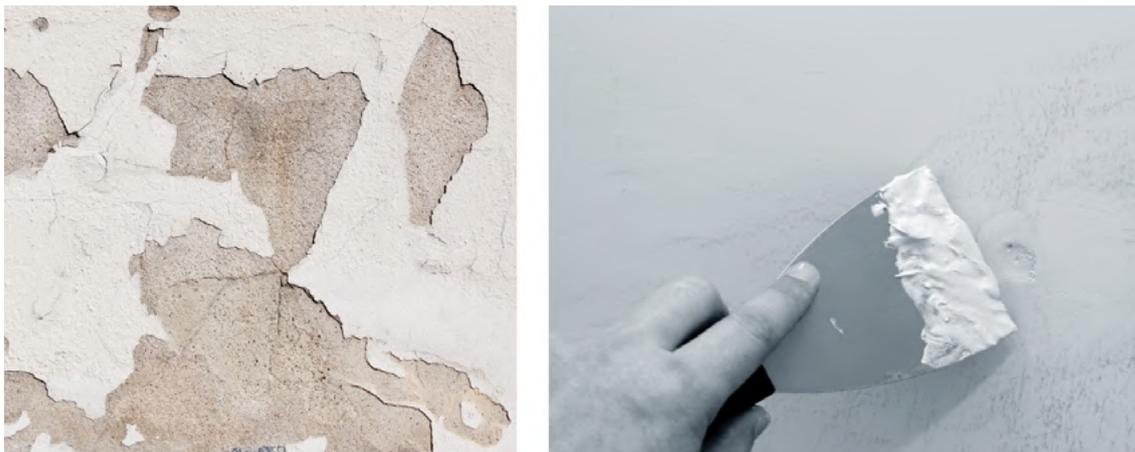
Figura 16. Ilustración de un revestimiento con desperfectos y aplicación de amasado de yeso para su reparación
