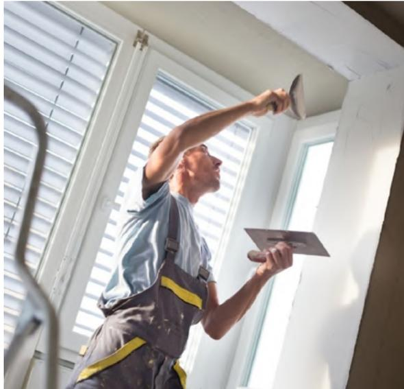
Figura 14. Ilustración de un instalador aplicando de yeso con espátula y llana
