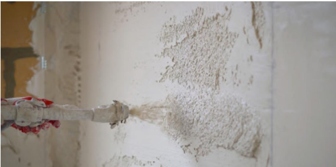
*Figura 17. Aplicación de un producto de yeso aplicado con una máquina de proyección*
