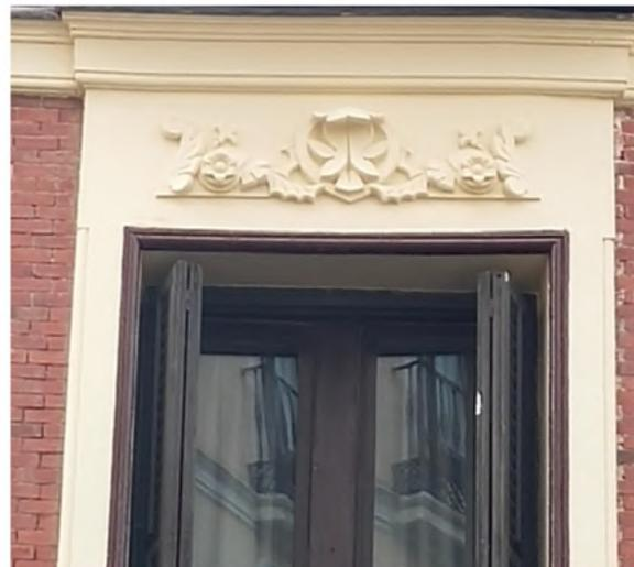
*Figura 33. Detalle de la rehabilitación del dintel de una ventana que presenta elementos decorativos en base yeso*
