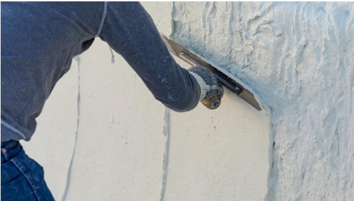
*Figura 18. Aplicación de la pasta de yeso en un paramento.*
